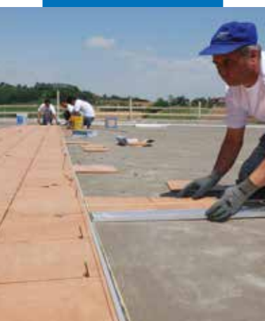
Lepenie dlažby lepidlom Kerabond + Isolastic
