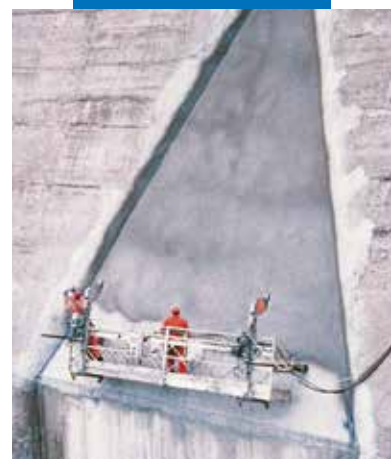
Mapelastic nanášaný nástrekom na vodnej priehrade
