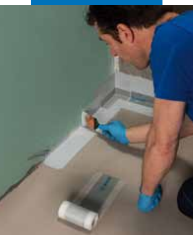
Inštalácia pásky Mapeband PE 120 s použitím Mapegum WPS
