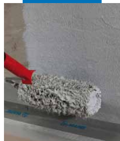
Aplikácia Mapegum WPS použitím valčeka
