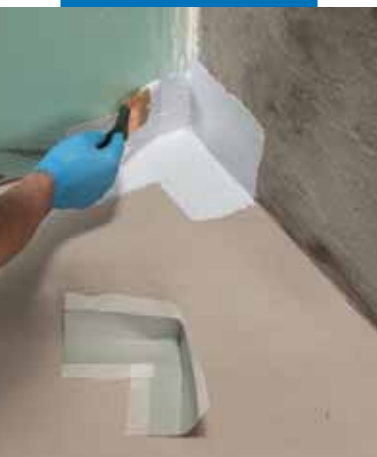
Inštalácia špeciálneho vnútorného rohu 90° Mapeband PE 120 s použitím Mapegum WPS
