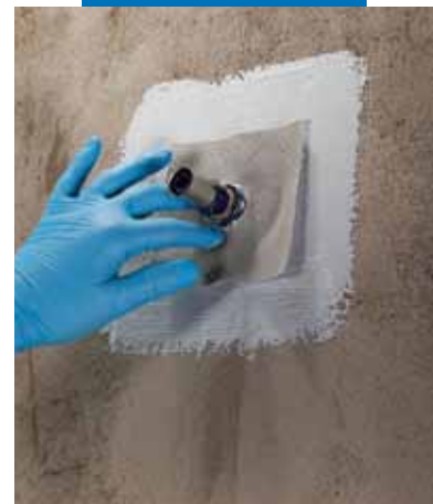
Utesnenie otvoru v stene s použitím manžety Mapeband PE 120 nalepenej do prvej vrstvy membrány Mapegum WPS
