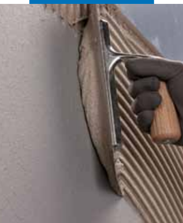
Inštalácia obkladových prvkov použitím lepidla Ultramastic III
