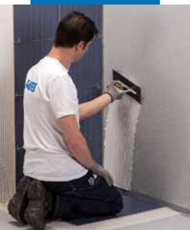
Inštalácia obkladových prvkov použitím lepidla Keraflex Maxi S1
